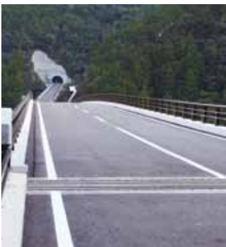
奥漣道路(Ⅱ期)区間
